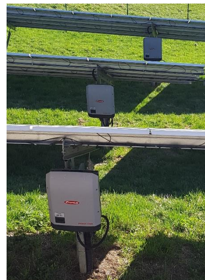
Abbildung 9 Wechselrichter der drei Modulreihen
